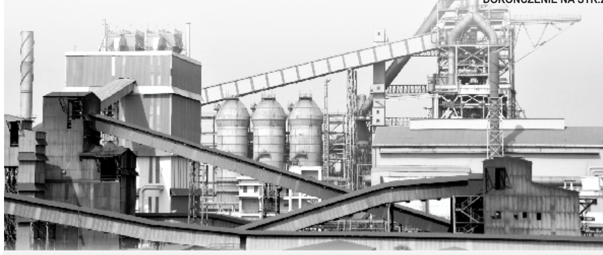
Wielki piec Huty SAIL's IISCO o pojemności 4160 m 3
