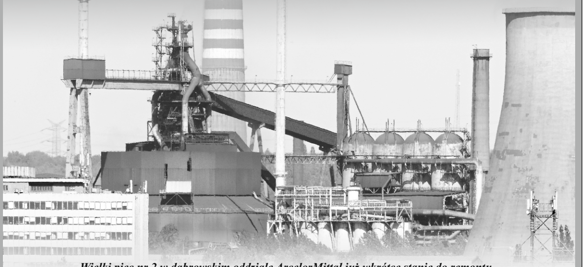
Wielki piec nr 2 w dąbrowskim oddziale ArcelorMittal już wkrótce stanie do remontu.
