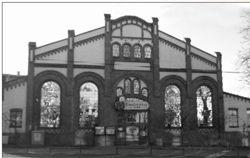
Przepięknie odrestaurowany budynek po dawnej walcowni.
