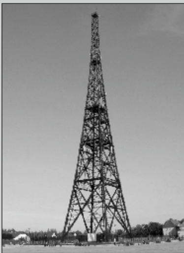
111 metrowa drewniana wieża radiostacji Gliwice.
