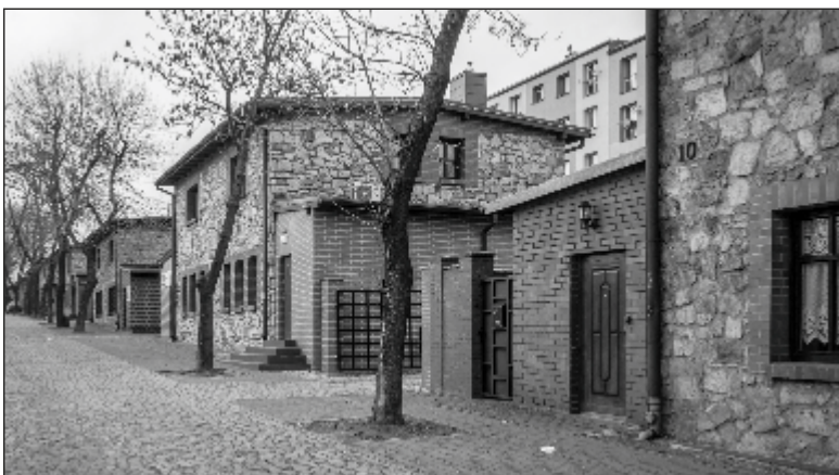
Kolonia robotnicza Ficusus została zbudowana z piaskowca.
