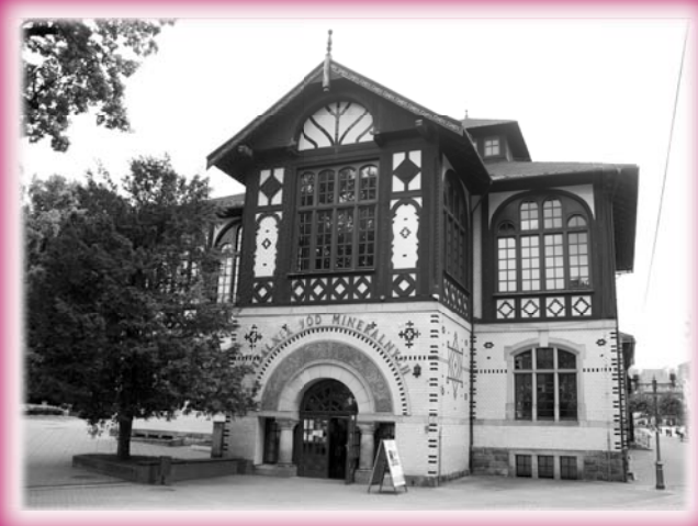
Czar dawnej architektury drewnianej – pijalnia wód mineralnych.
