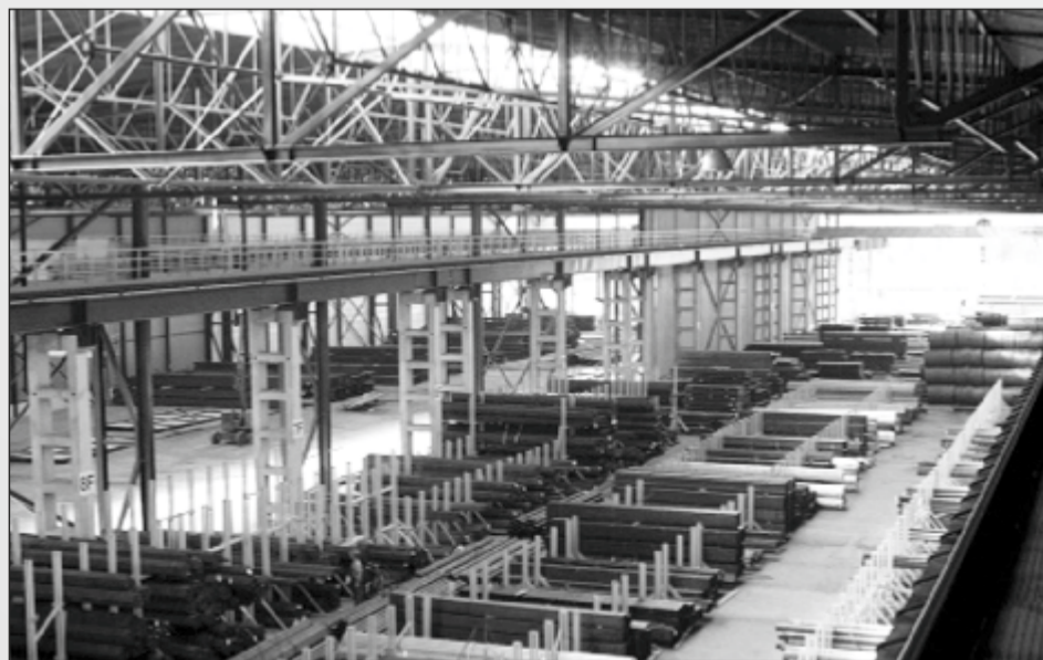
W roku bieżącym Stalprofil zamierza wydać na inwestycje 18,5 mln złotych. Na składzie Katowicach ma zostać zakończona budowa nowoczesnego, w pełni zautomatyzowanego magazynu wysokiego składowania.
